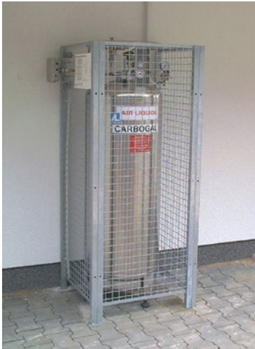
Abb. 5 Aufstellungsbeispiel für einen stationären Druckbehälter
